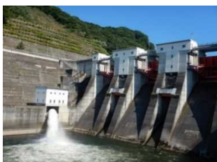
御所ダムからの『非常時補給』状況(7月31日撮影)
