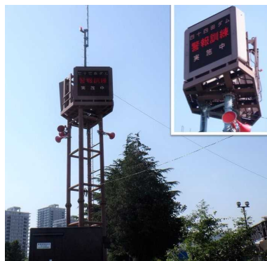
○ダム警報表示設備(左:大型電光表示板、右:小型電光表示板)
