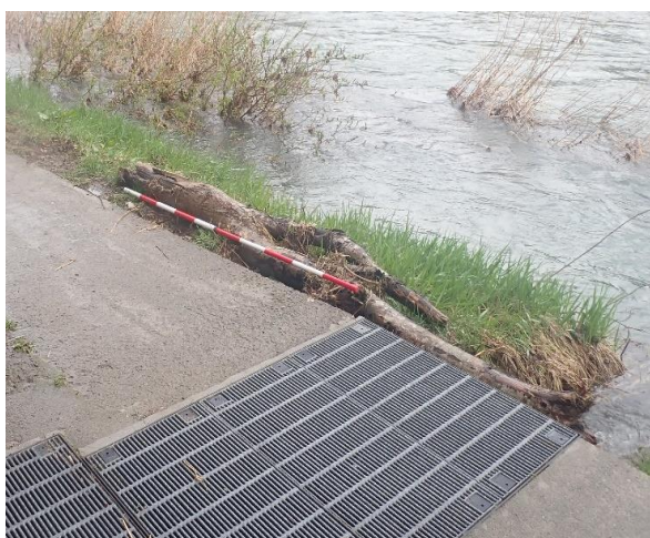
■中津川河川公園（上の橋右岸直下） 散策路脇洗掘 → 土のう設置による補修完了 【4/18実施】
