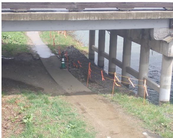
■中津川河川公園（上の橋右岸直下） 散策路脇洗掘 → 土のう設置による補修完了 【4/18実施】
