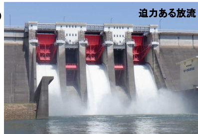
クレストゲートからの点検放流状況
