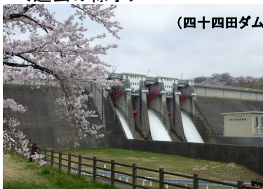
クレストゲートからの点検放流状況
