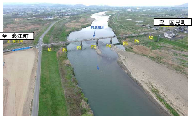
▲伊達崎橋 全景
