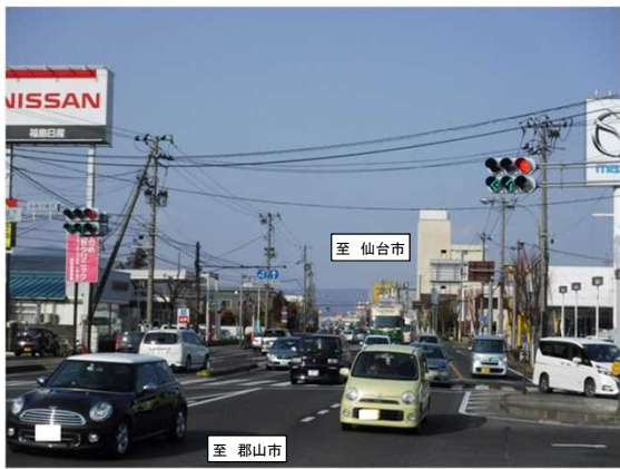
▲ 国道4号の電柱状況 •電線共同溝の整備により、災害時における緊急輸送道路の確保等が図られます。
