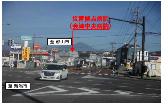
▲ 国道49号の電柱状況
