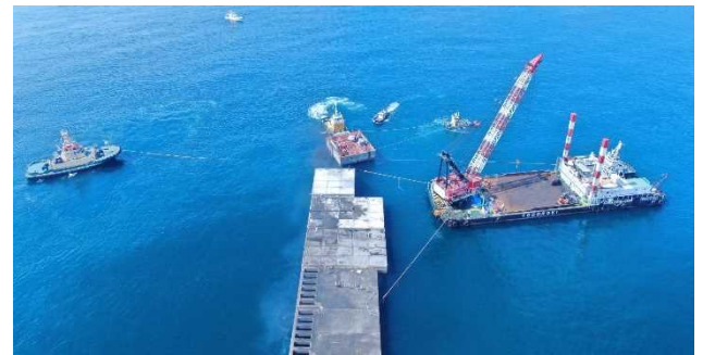
▲防波堤整備の様子(ケーソン※据付)
