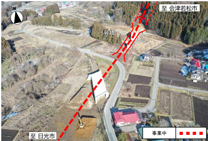
▲湯野上バイパスの周辺状況
