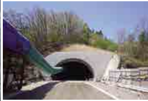
ななつくぼ ② 七ツ窪トンネル
