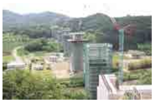
つきだて ④ 月館高架橋
