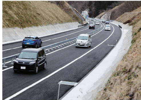
阿武隈東道路 供用後
