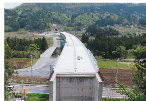
よこかわ ④ 横川高架橋
