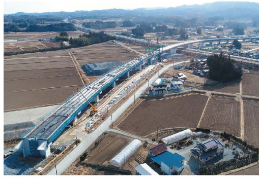
いまだ ② 今田高架橋
