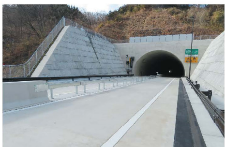
④馬館山トンネル
