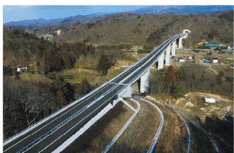
③月館高架橋
