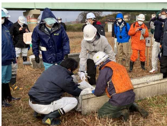
側溝（小河川）での油流出防止対策
