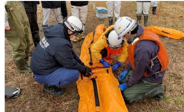
準備工（オイルフェンス連結）
