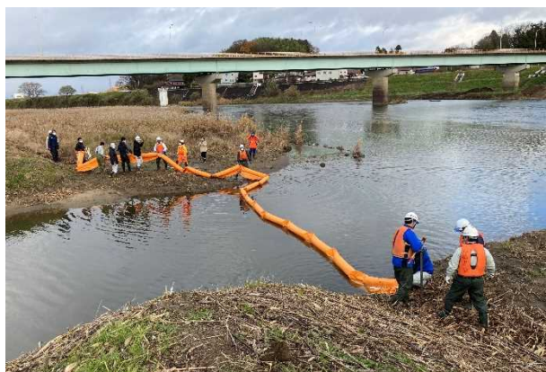
オイルフェンス設置
