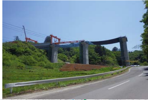
4 めのかわ 布川大橋
