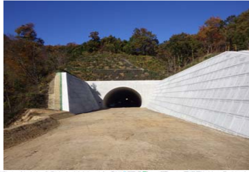
② まだてやま 馬館山トンネル
