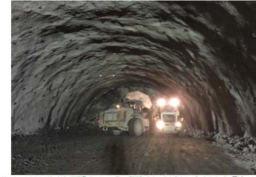
⑥ こしめぐり 腰巡トンネル
