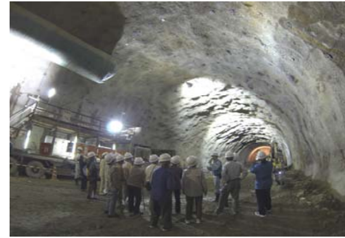
3 セツ窪トンネル
