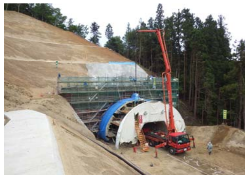
5 こんべんぞう 金弁蔵トンネル
