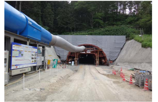
7 庄司淵トンネル
