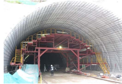
6 こしめぐり腰巡トンネル
