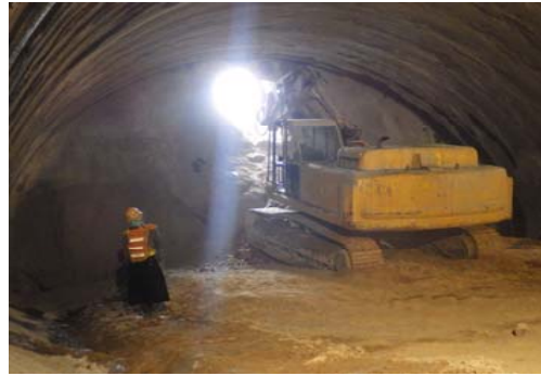
2 馬館山トンネル
