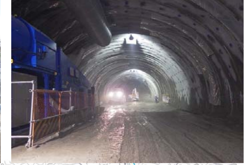
しょうじぶち 7 庄司淵トンネル
