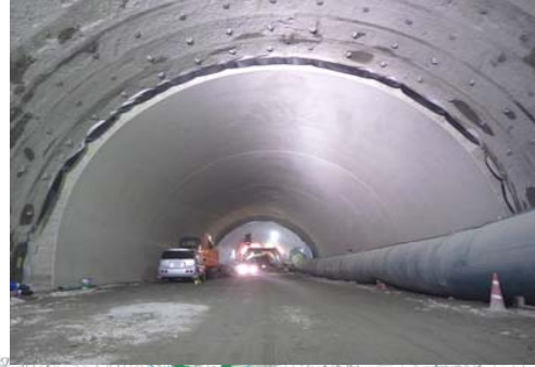
ななつくぼ 3 セツ窪トンネル
