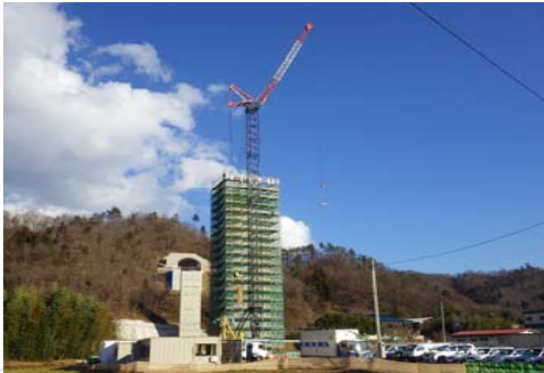
つきだて 2 月館高架橋
