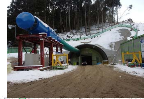
こしめぐり 6 腰巡トンネル
