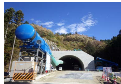
5 こんべんぞう 金弁蔵トンネル
