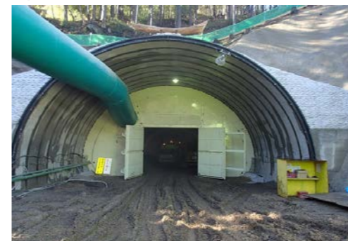
6 こしめぐり 腰巡トンネル
