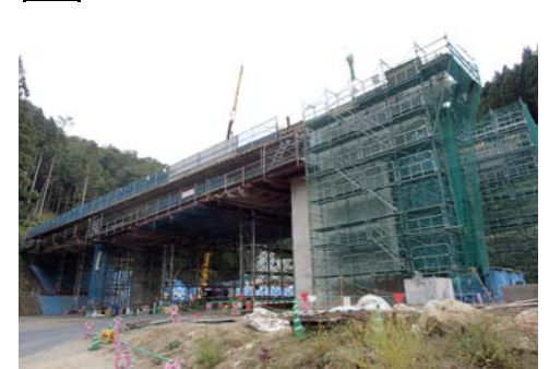
7 くまやしき 熊屋敷橋
