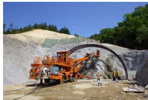
② まだてやま 馬館山トンネル
