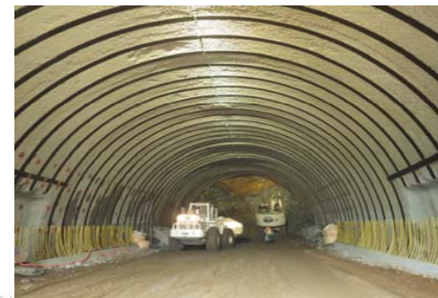
⑤ こんべんぞう 金弁蔵トンネル
