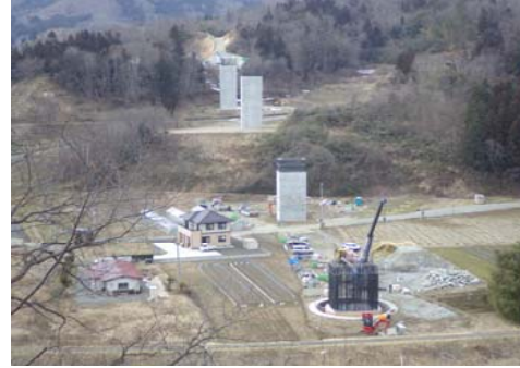
2 つきだて 月館高架橋
