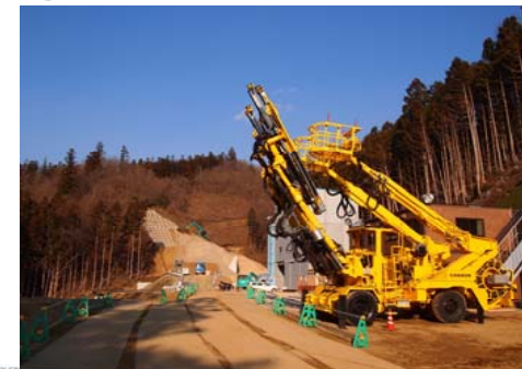
5 こんべんぞう 金弁蔵トンネル
