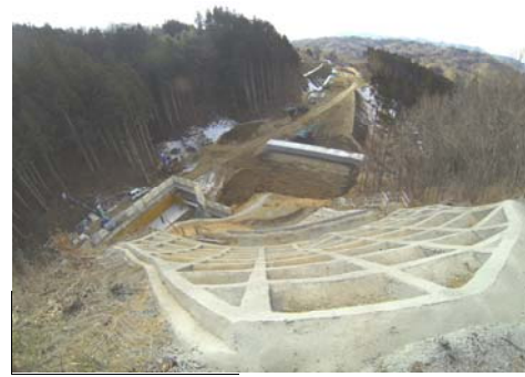
5 こんべんぞう 金弁蔵トンネル
