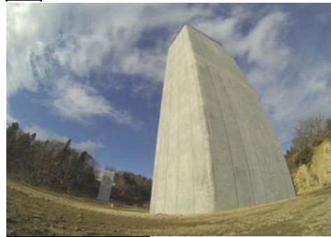
2 つきだて 月館高架橋
