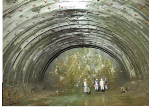
3 ななつくぼ セツ窪トンネル
