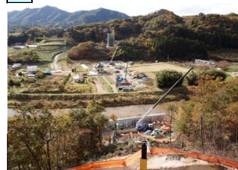
2 つきだて 月館高架橋
