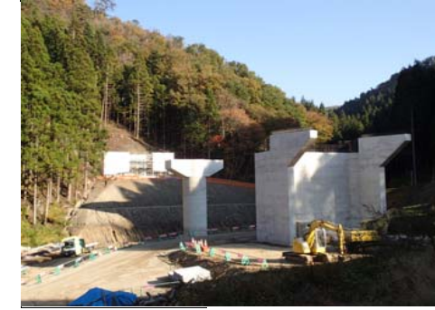
7 くまやしき 熊屋敷橋
