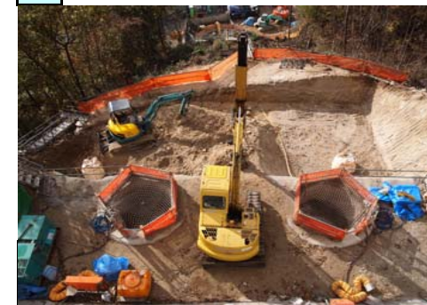
2 つきだて 月館高架橋
