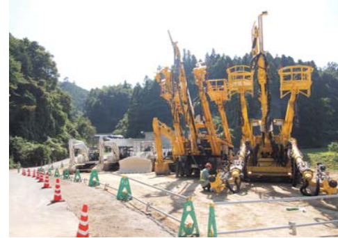
3 セツ窪トンネル
