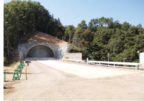
3 セツ窪トンネル
