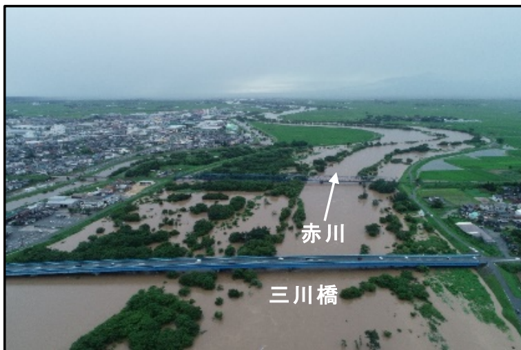
鶴岡市 三川橋付近 令和2年7月出水状況
