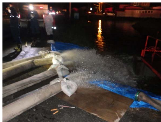
▲鶴岡市湯ノ沢内 排水ポンプ車稼働状況
