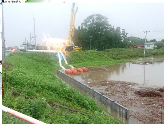
▲三川町青山地内 排水ポンプ車稼働状況
