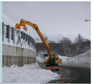
雪堤除去作業
