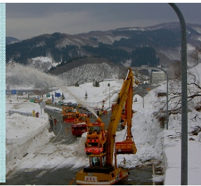
雪崩発生時除雪状況
