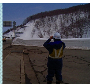
パトロール時法面点検
