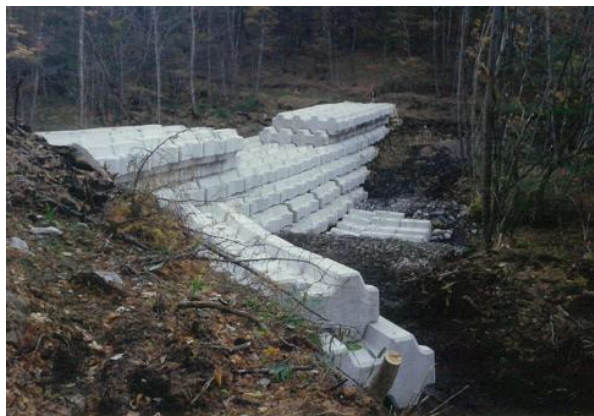
コンクリートブロックによる 仮設砂防堰堤
