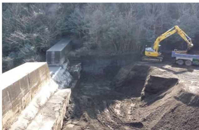
既設砂防堰堤の除石
