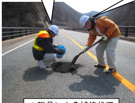
▲職員による補修状況
