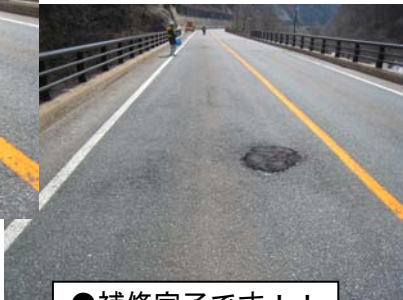
●補修完了です！！
