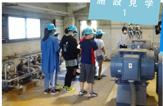
洪水時などに、田畑の水没を防ぐ施設 畔藤排水機場
