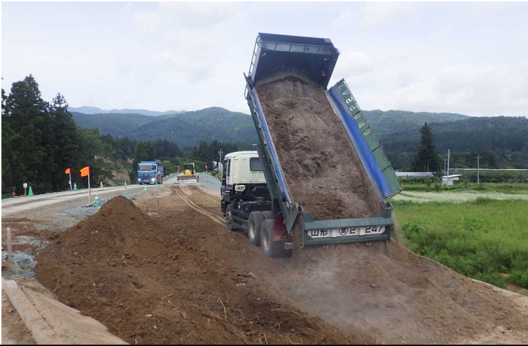
河道掘削工事において掘削した土砂を長島地区の築堤工事の盛土材として活用
