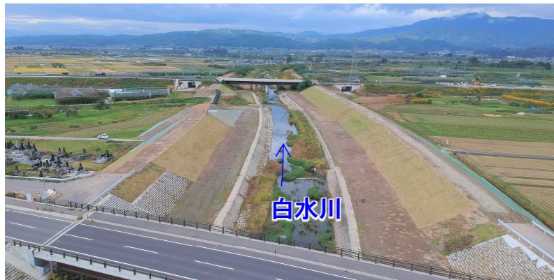
堤防整備状況
