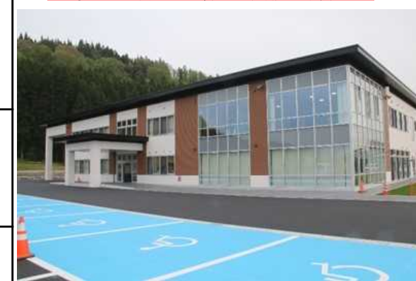
令和3年3月に完成した舟形町の福祉避難所「てとて」
