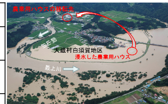
令和2年7月洪水により浸水した大蔵村白須賀地区
