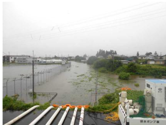
山形市樫沢 王川内水被害状況
