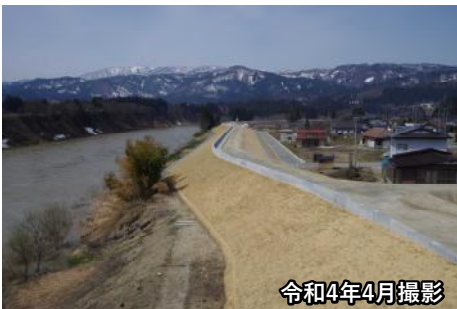
村山市長島地区 堤防整備状況
