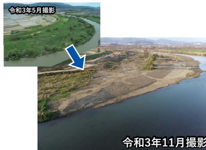
河北町谷地地区 河道掘削状況
