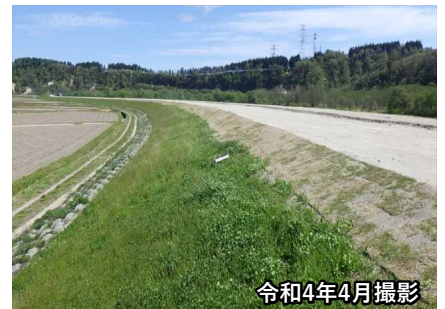
大蔵村白須賀地区 堤防整備完了
