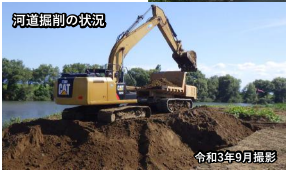
掘削土の土質改良
