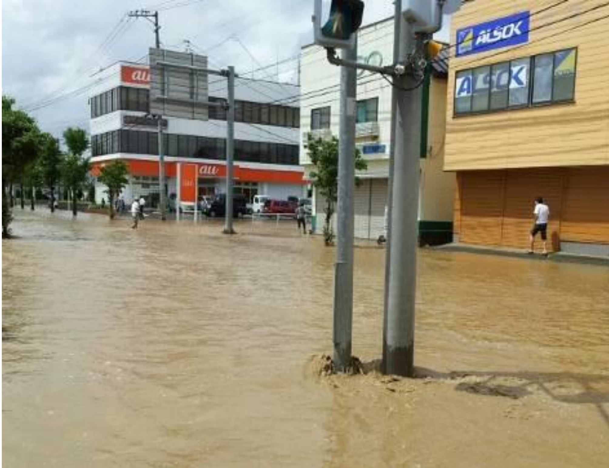
南陽市街地冠水状況
