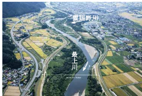
長井地区の樹木状況
