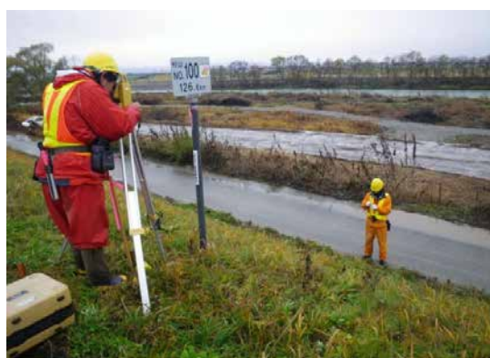
河川横断測量の様子
