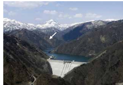
長井ダム (平成 23 年完成)
