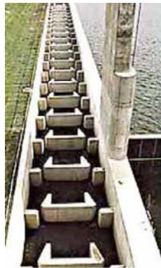
下流側から見た魚道
