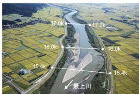
最上川下流部の砂州の状況
