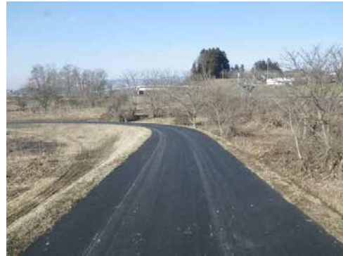
堤防の天端舗装補修後の状況
