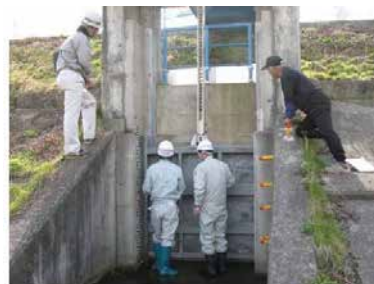
樋門・樋管の点検状況
