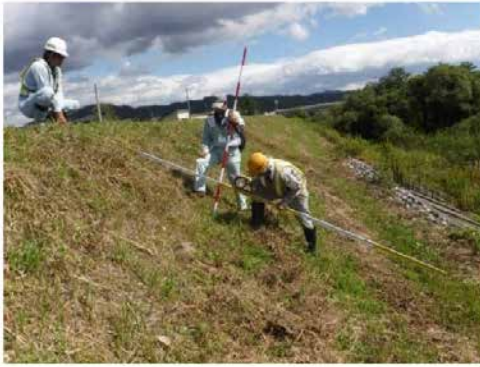
除草後の堤防点検
