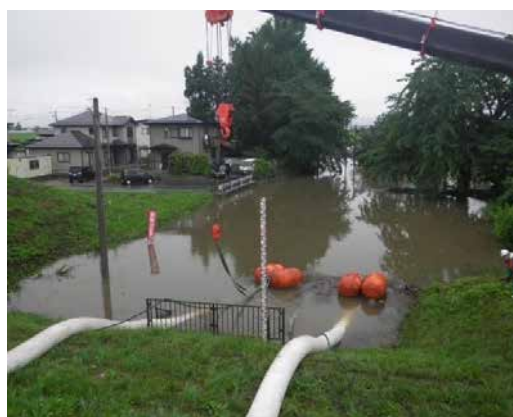
須川の増水による内水状況 (山形市志戸田地区)
