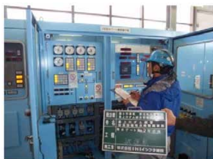
ゲート設備点検
