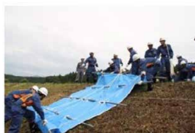
【最上川中流】 シート張り工の訓練実施（真室川）
