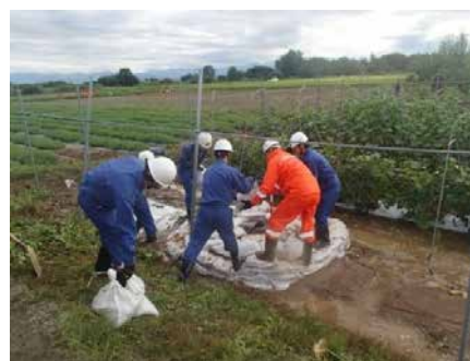
漏水による水防活動状況 (釜段工法)
