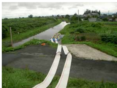
内水氾濫排水ポンプ車設置 (王川排水樋門)
