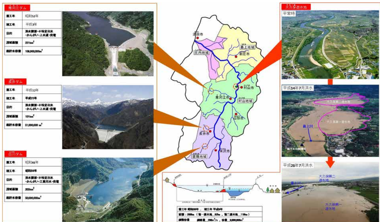
図 3-8 洪水調節施設の整備状況（平成 29 年 3 月末時点）
