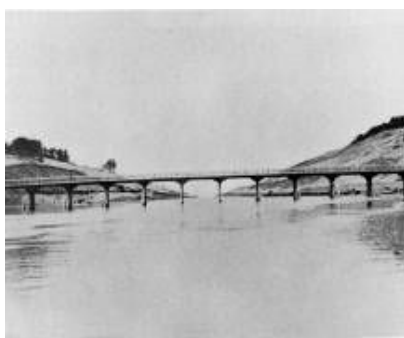
赤川放水路一部通水後（昭和3年）
