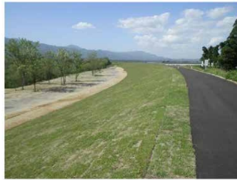
堤防補修後（堤防植生不良により、芝張替実施）
