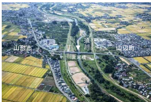
須川：三河橋付近
