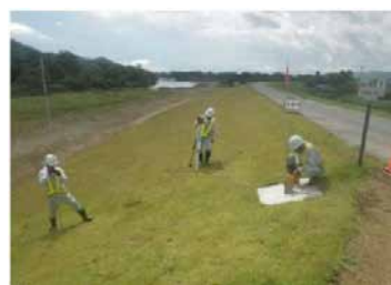
定期横断測量状況
