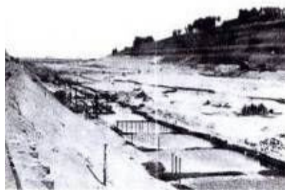
放水路開削工事の様子（昭和8年）
