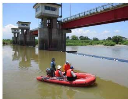
河川巡視（船上）の状況
