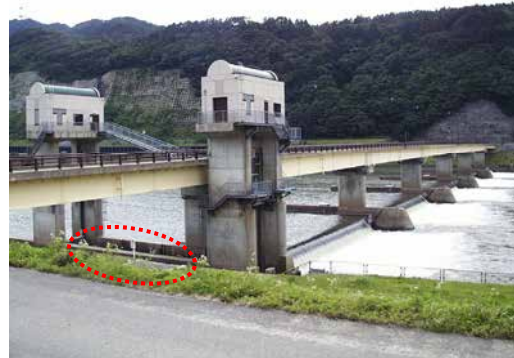
最上川さみだれ大堰
