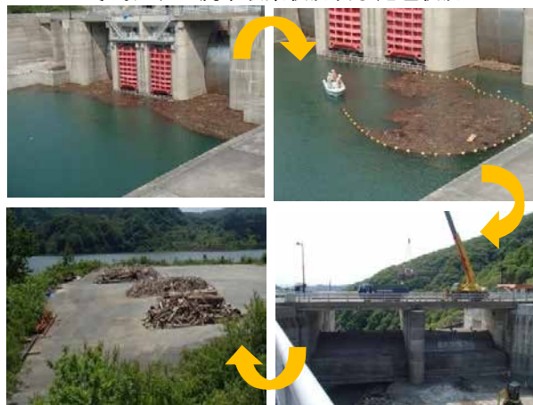
寒河江ダム流木収集状況及び処理状況
