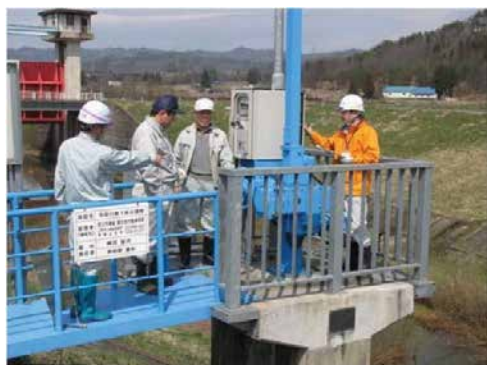
施設点検（樋門ゲート設備）の状況
