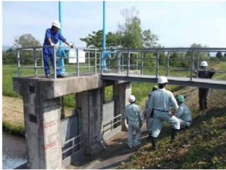
樋門樋管点検
