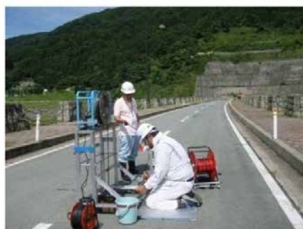
ダム天端の埋設機器観測状況
