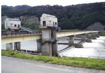
最上川さみだれ大堰
