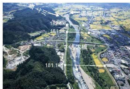
最上川上流部の砂州の状況
