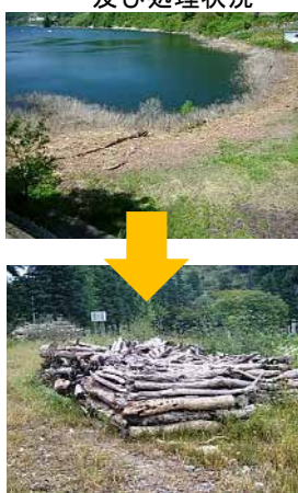
白川ダム流木撤去前及び処理状況
