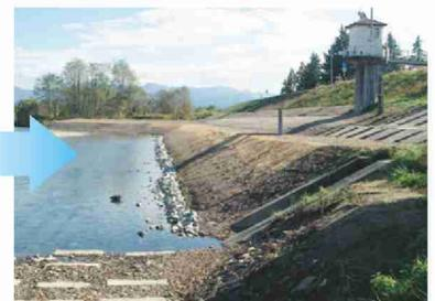
洪水により被災した護岸の災害復旧
