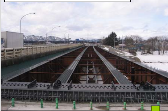
上部工工事完了後（橋桁設置）
