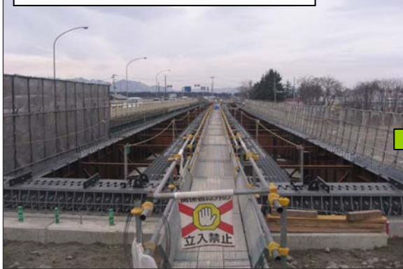
橋桁の上に安全通路等を設置
