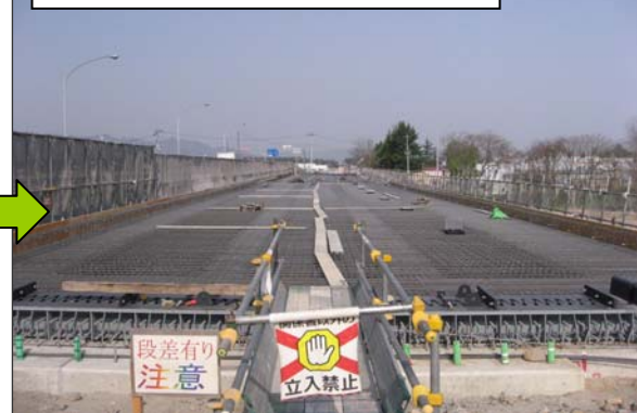
鉄筋・型枠を設置
