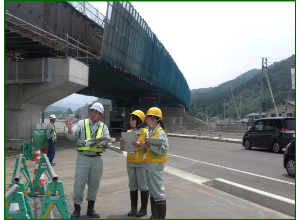
↑万世高架橋上部工工事にて 架設状況を確認
