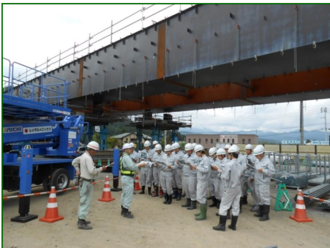
↑万世高架橋上部工工事にて工事説明を受ける
