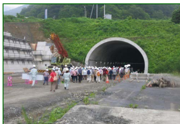
↑ 栗子トンネル見学(第4代目 現在建設中)
