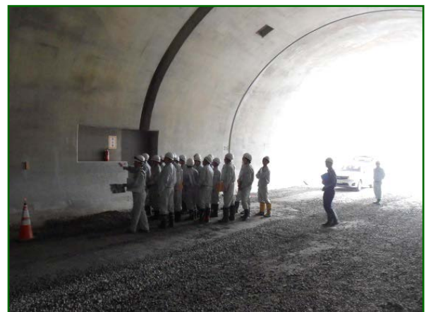
←栗子トンネル坑口にて工事説明を受ける
