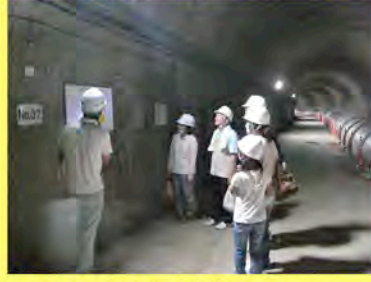
ダムの地下60mを探検↑
