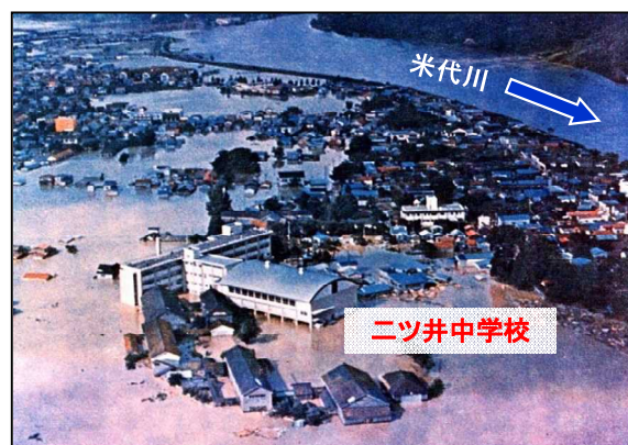
昭和47年7月洪水による被災状況 (旧二ツ井町中心部)
