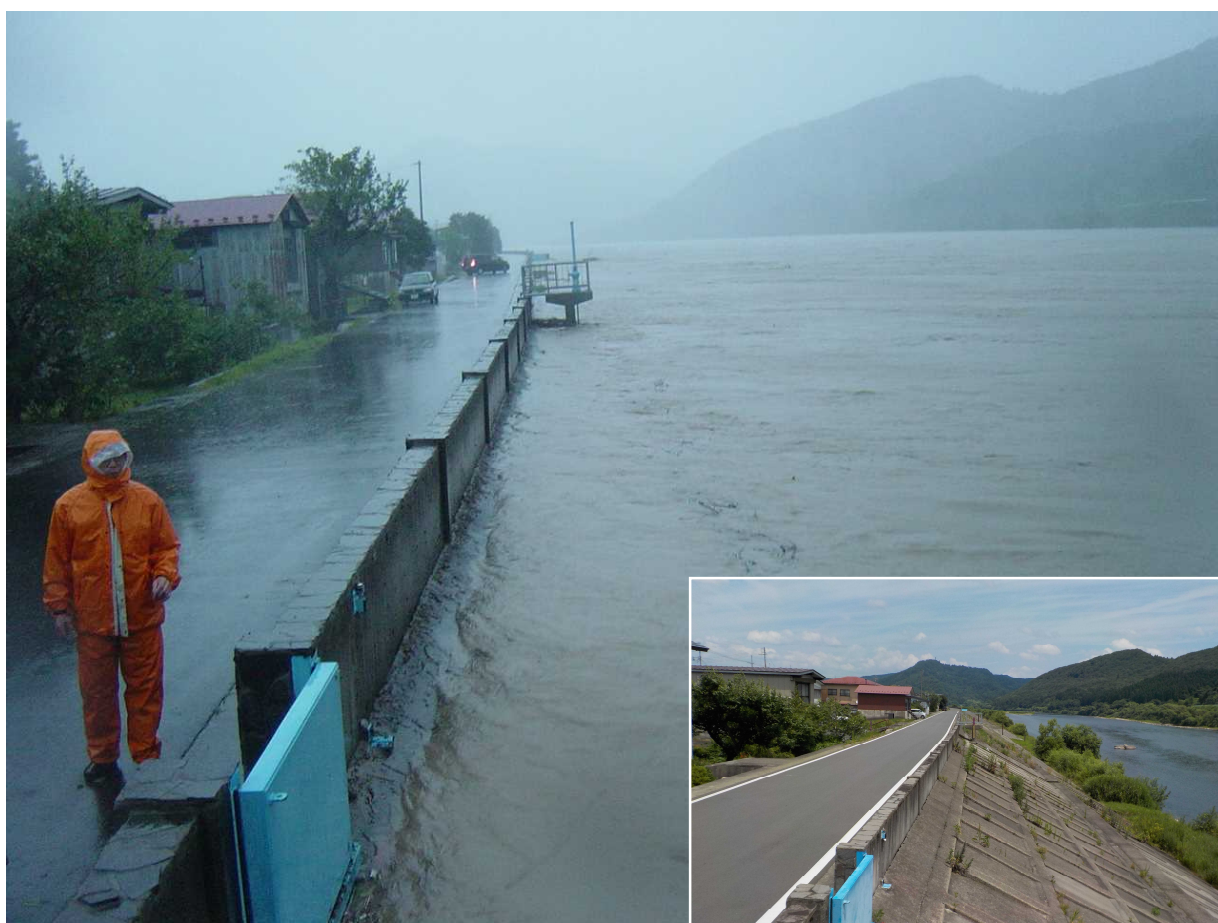
H19.9洪水時の二ツ井観測所付近の状況（H19.9.18 5:30）
