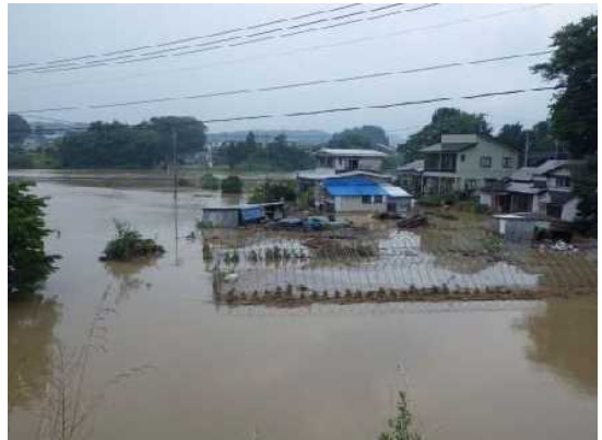
平成25年8月洪水による被災状況 (大館市早口出口地区：県管理区間)
