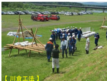
【川倉工法】 水防訓練の実施状況（北秋田市）
