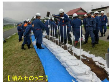
【積み土のう工】 水防訓練の実施状況（大館市）
