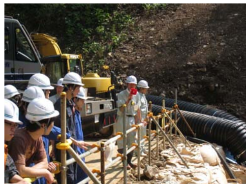
砂防えん堤 施工現場見学
