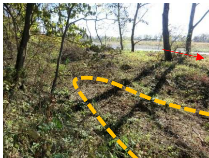
▲土砂の堆積状況
