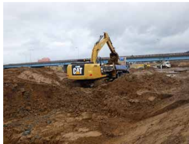
掘削土砂積み込み
