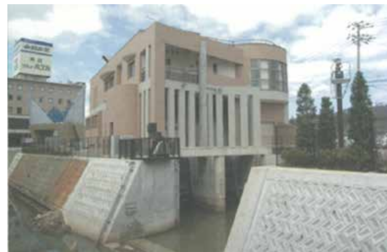
大沢川排水機場吸水口
