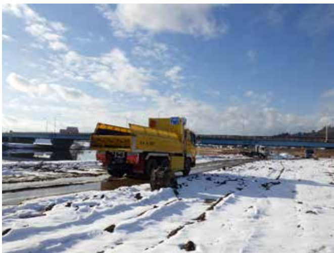
掘削土砂運搬
