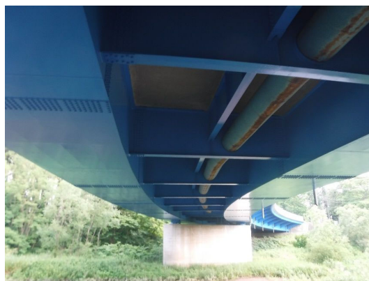
写真4-9 【対策】塗替塗装
