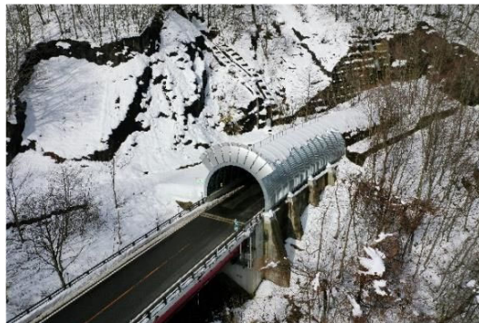
写真4-13 【全景】山紫スノーシェルター
