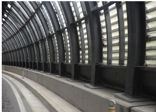
写真4-18 【対策】 沓座モルタルの打換え
