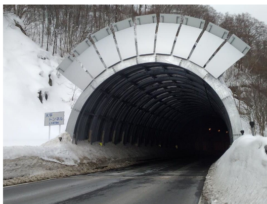
写真4-15 【対策】完成(更新)
