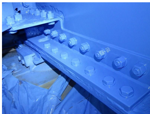
写真4-12 【対策】 主桁当て板補修・再塗装
