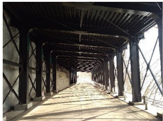
写真4-21 【対策】 鋼材部再塗装
