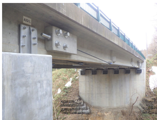
写真4-3 【対策】 ケーブル工・落橋防止装置工
