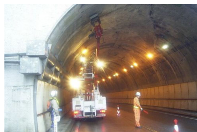
写真2-2 トンネル点検状況
