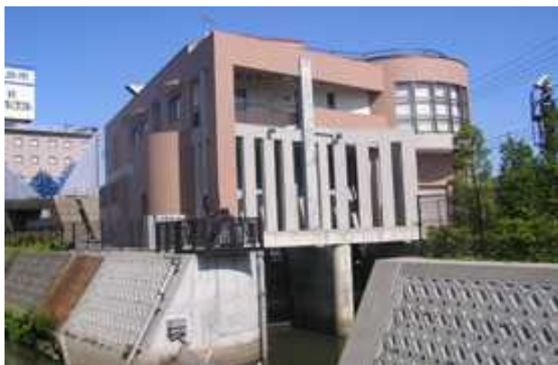
大沢排水機場
