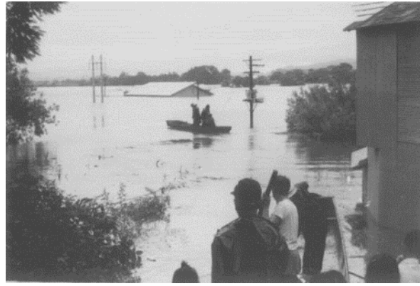
昭和 47 年 7 月洪水による被害状況 (旧本荘市薬師堂)
