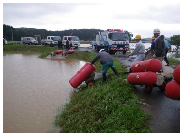
子吉川左岸（森子地区）の排水作業状況 平成23年6月洪水時
