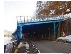
国道46号 生保内スノーシェッド
