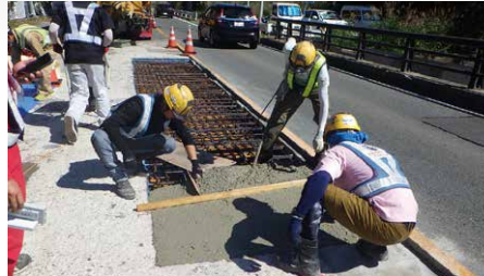
損傷部分を補修中
