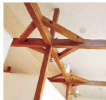
斜材による補強
