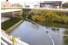
オイルフェンス 流出した油をせき止めている旭川の様子
