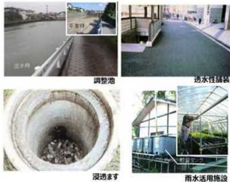
雨水貯留浸透施設の例
