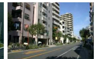
沿道建築物の不燃化
