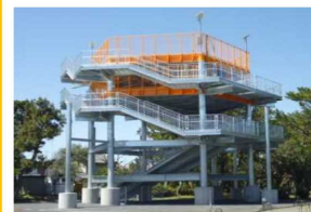
津波避難タワー
