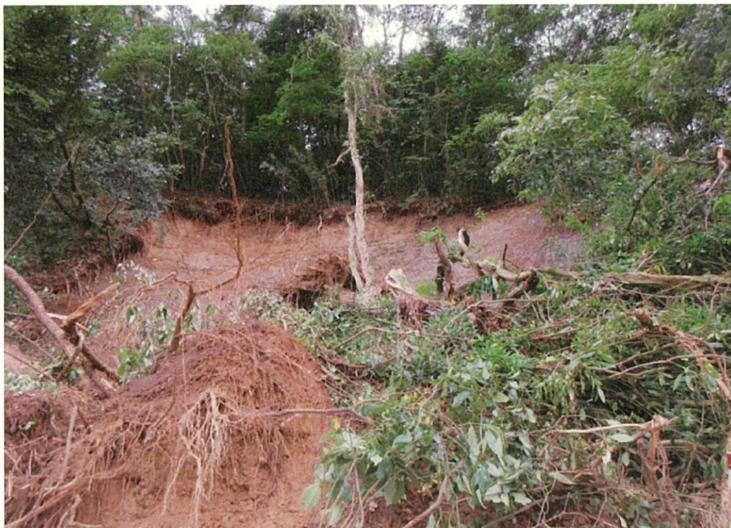
⑤土砂崩れ
