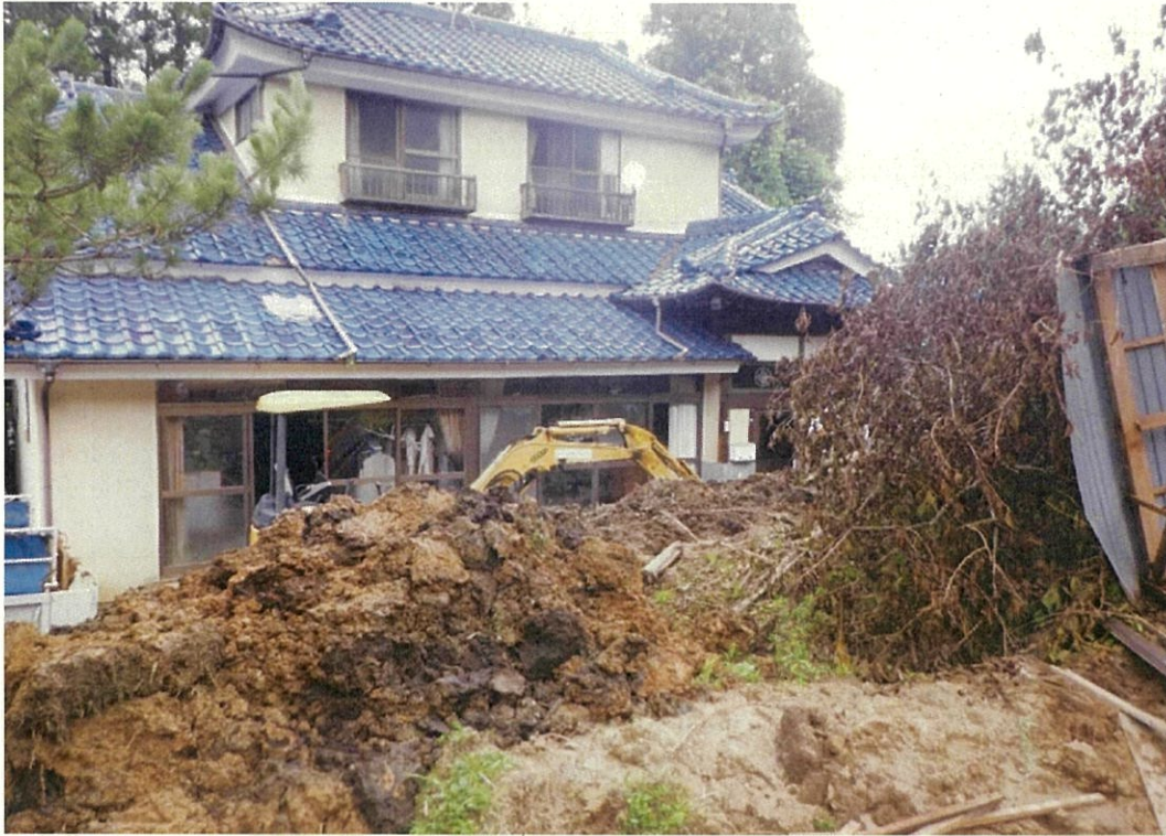
⑪宅地の土砂崩れ
