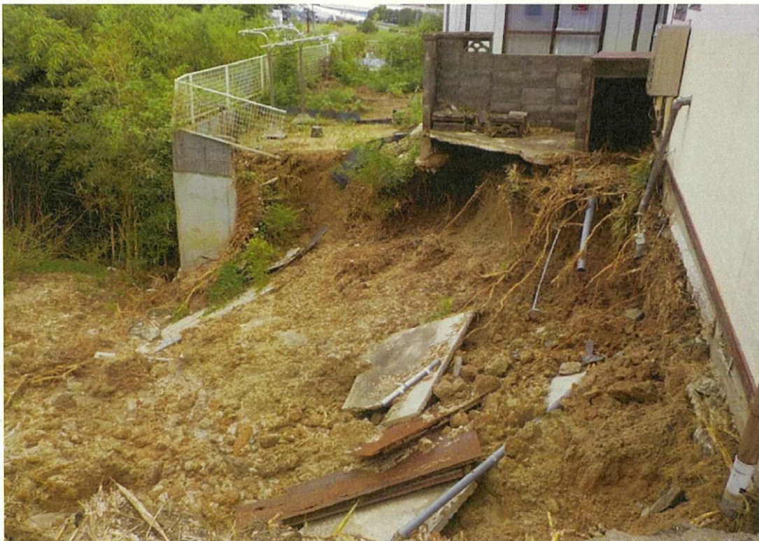
⑧宅地の土砂崩れ
