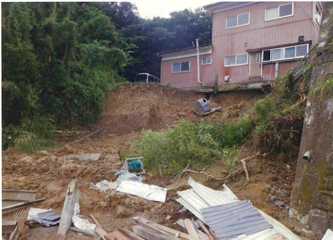
⑩宅地の土砂崩れ
