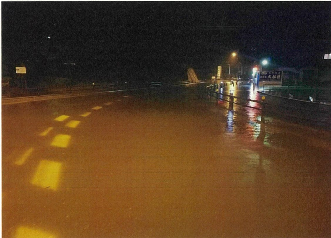
②国道45号の冠水状況（松島海岸）
