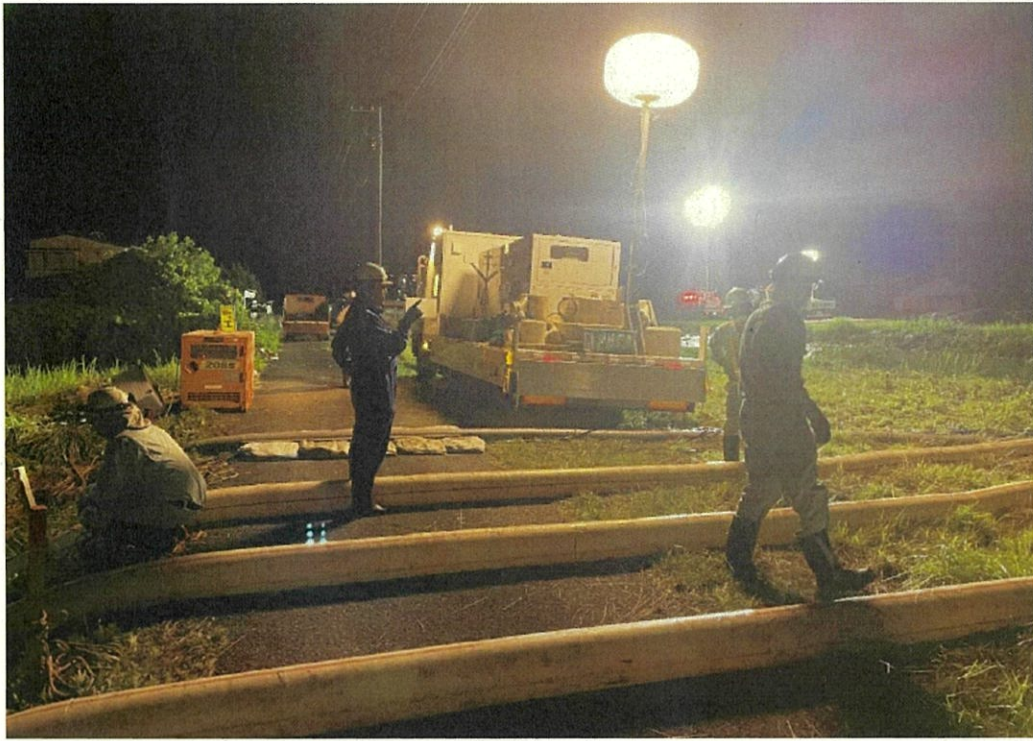
⑮国土交通省排水ポンプ車による排水作業
