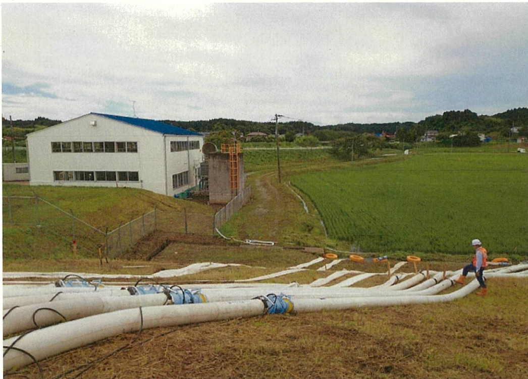
⑯国土交通省排水ポンプ車による排水作業
