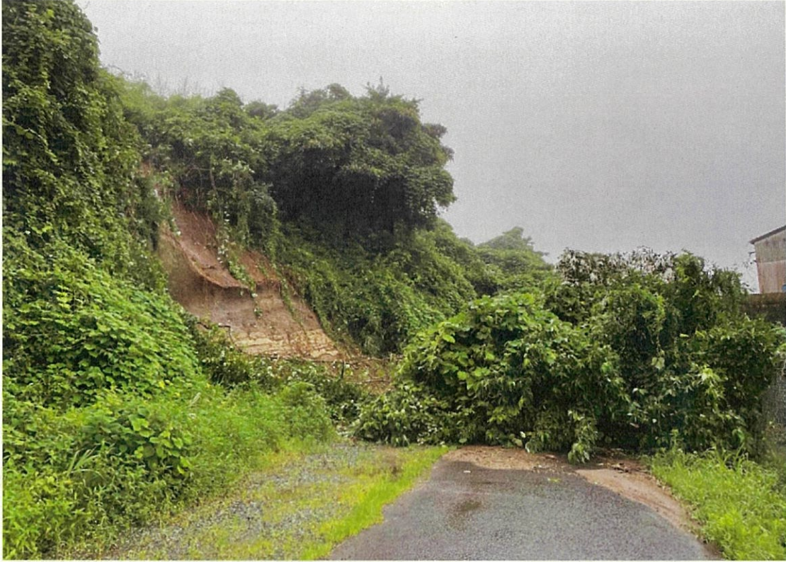
③町道への土砂崩れ
