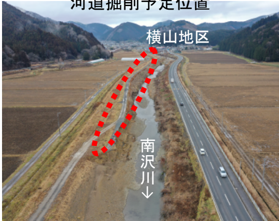
河道掘削イメージ
