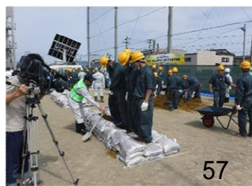
▲中詰め土を締め固める様子
