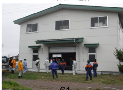
▲中田町水防倉庫の巡視
