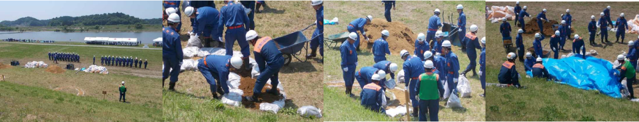
土のう 1段敷設 (小口積み & 長手積み)
