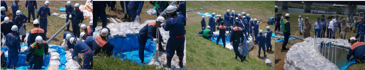
土のう5段敷設後、杭打ち固定
