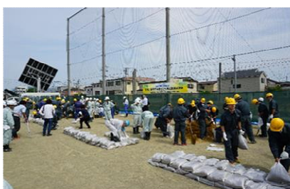
▲積土のう工の全体状況
