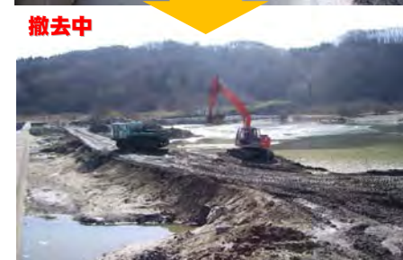
土砂撤去の状況(貯砂ダム)
