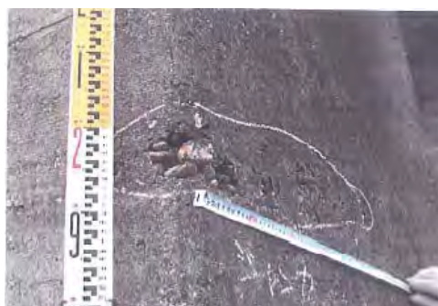
門柱の破損
