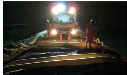
TEC-FORCE の派遣状況 (H23.3.13～ 名取川排水ポンプ車稼働)
