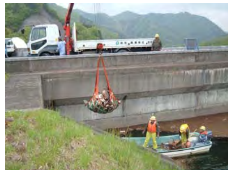
釜房ダム 流木処理
