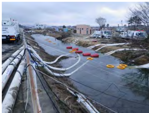
排水ポンプ車による緊急排水の活動状況 (仙台市 井土地先)
