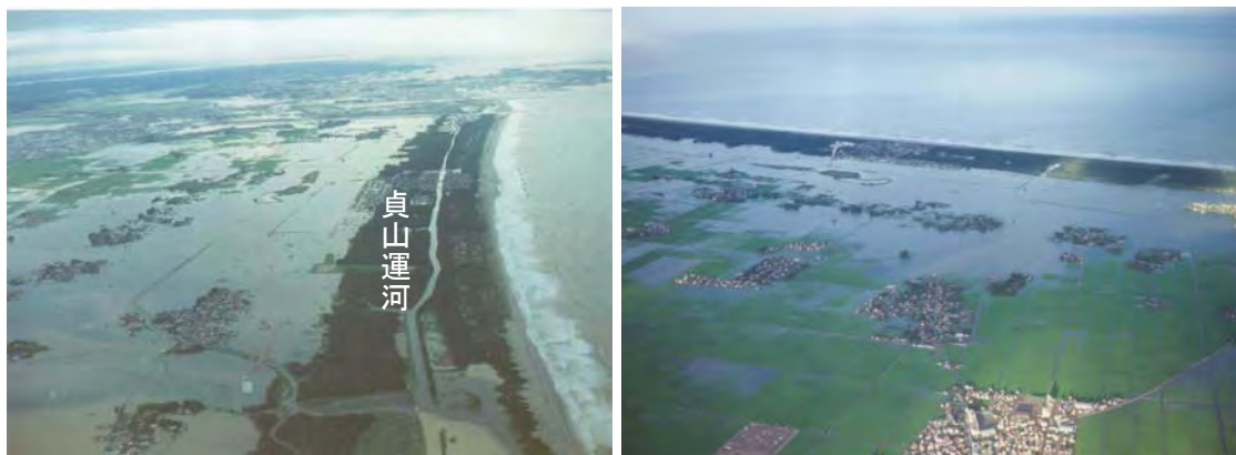
昭和 61 年 8 月洪水時の浸水状況（名取川下流部左岸）
