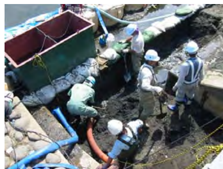
取水ポンプ場土砂撤去作業
