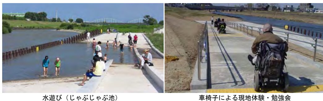
広瀬川地区 整備状況
