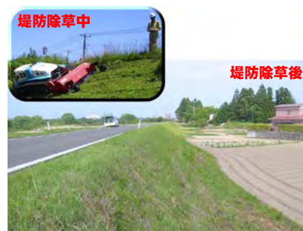
堤防の除草状況
