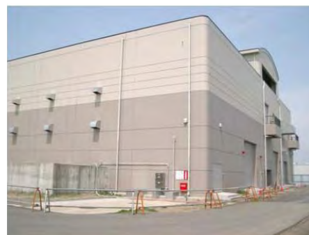
長町第一ポンプ場 (仙台市下水道)
