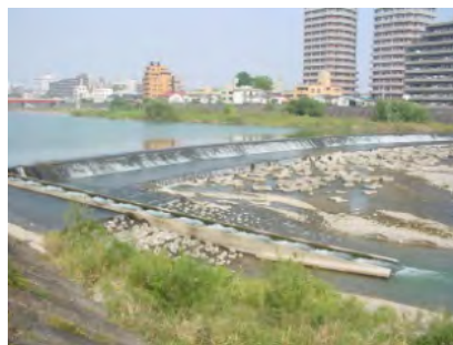
郡山堰（広瀬川 4k 地点）
