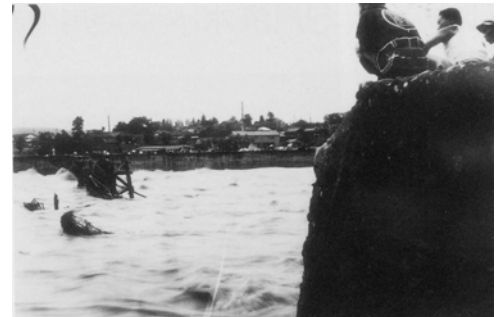
評定河原橋の流出
