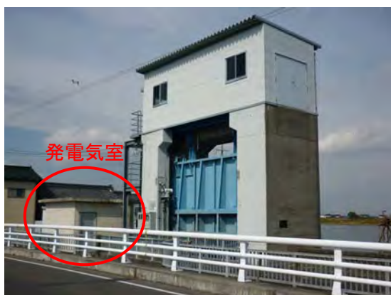
閉上水門(地震前)
