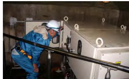
放流設備の点検
