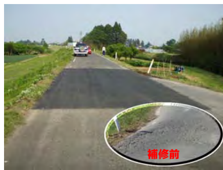
広瀬川堤防天端舗装状況
