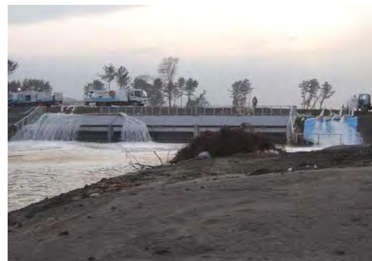
排水ポンプ車による緊急排水の活動状況 (仙台市 井土地先)
