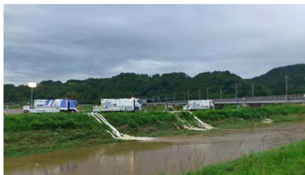
排水ポンプ車の活動状況
