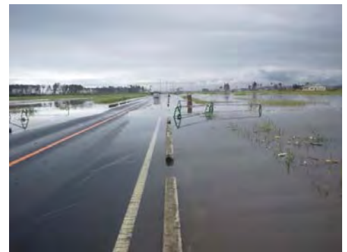
台風15号(平成23年9月)による浸水状況(仙台市若林区井土地先)
