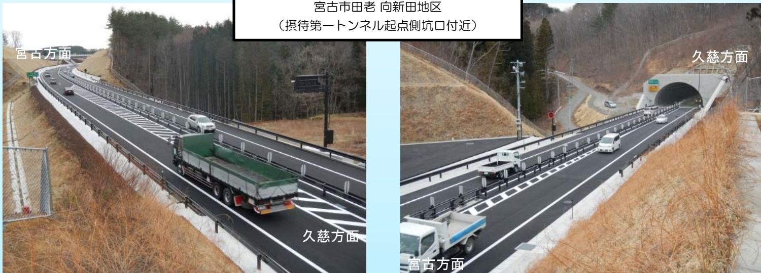
岩泉町 小本地区 (岩泉小本トンネル終点側坑口付近)
