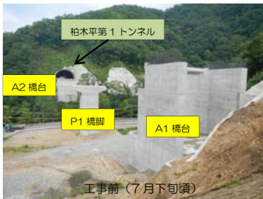
工事前（7月下旬頃）
