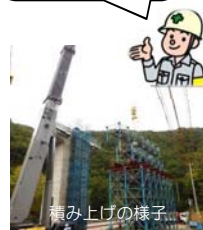
積み上げの様子
