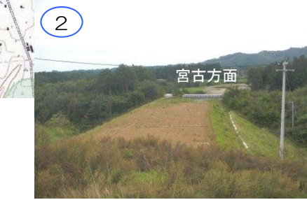
島越地区の盛土区間です。盛土は完成形に仕上がっています。仕上げの工事(舗装工事)が残っています。
