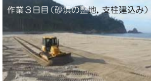
作業3日目(砂浜の整地、支柱建込み)
