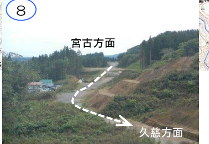
(仮称)田野畑ICの中央部付近です。本線部や久慈方面への出口道路の工事を今後整備します。
