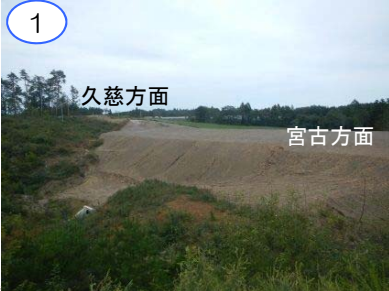
大芦地区の深く広い沢部の埋め立て(盛土)工事を進めています。
